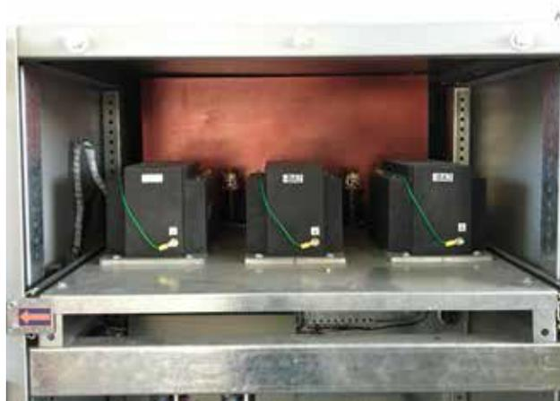
**B:** zona de control, en la cual alojamos la circuitería, cableado, alimentación y relevador de protección.
