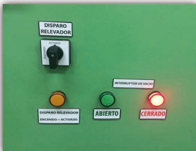
Figura 1.1: Selector de disparo por relevador (posición activado) y Lámparas indicadoras
